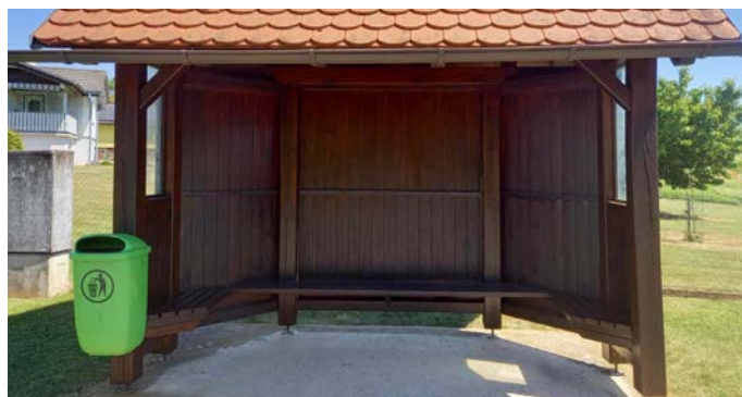
Schaut wieder aus wie neu: Das Bushaltehäuschen am Mitterberg in Rohrbrunn
