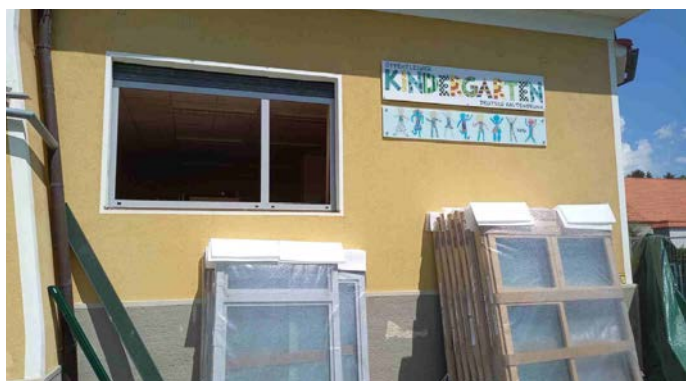
Die Fenster im Altbau wurden ersetzt.
