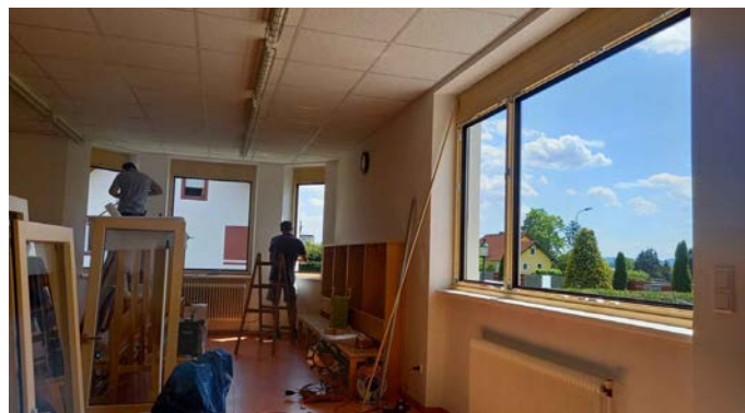
Die Montage erfolgte durch Fa. Berger aus Rohrbrunn.
