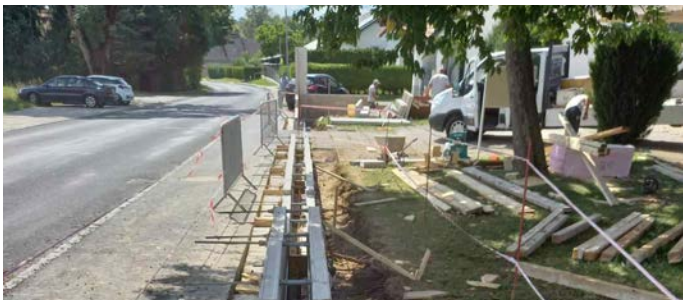
Ein neuer Betonsockel als pflegeleichtes und langlebiges Fundament für die neue Einfriedung
