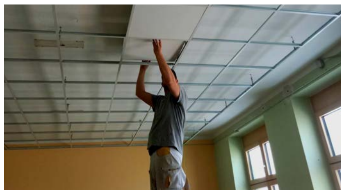
Neue Schallschutz-Zwischendecken mit LED-Beleuchtung für die Kindergarten-Gruppenräume.
