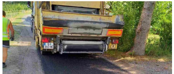
Durch Spritzdecken mit Rollsplittschicht wurden Risse, Ausbrüche und Setzungen behoben.
