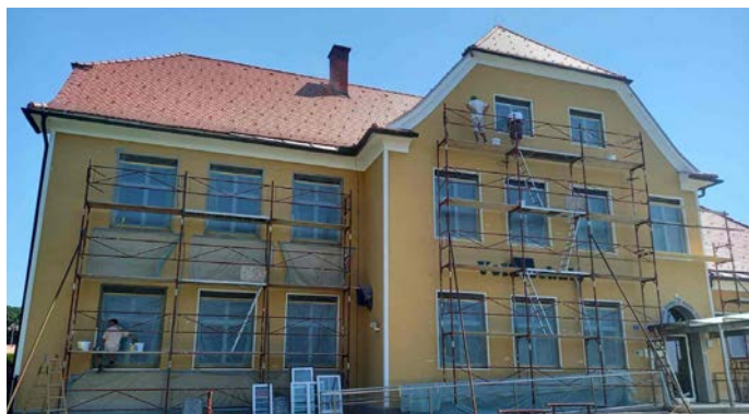
Im Sommer wurden umfassende Sanierungen durchgeführt.
