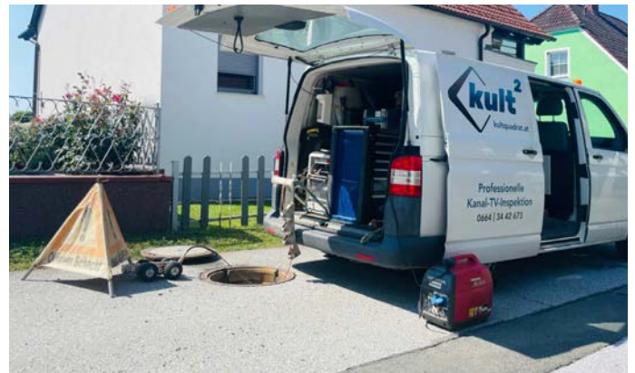
Die Firmen Stipits und kult 2 erheben den Ist-Zustand des Leitungsnetzes.
