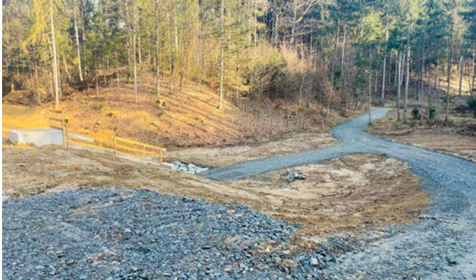
Retentionsbecken: Am Hang
